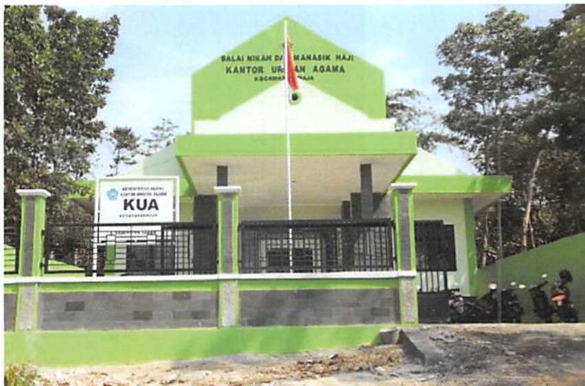
Gambar 3.18 Progress Pembangunan KUA Maja
