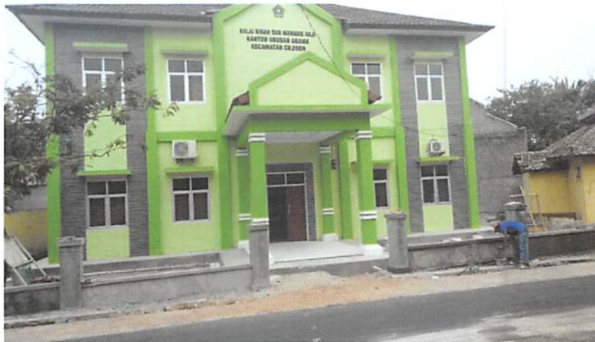
Gambar 3.17 Progress Pembangunan KUA Cilegon
