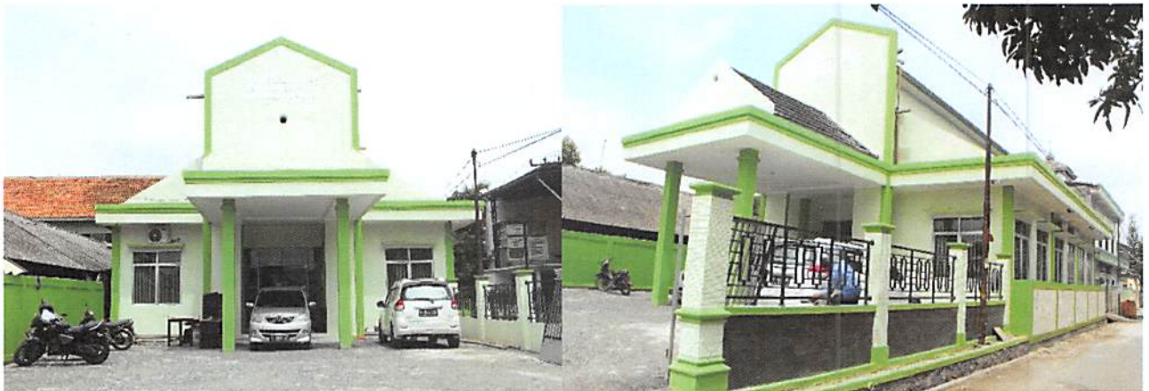
Gambar 3.20 Progress Pembangunan KUA Cikande
